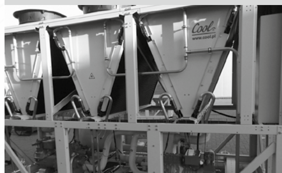
Konstrukcja chillera to otwarta rama z odseparowaną częścią elektryczną uniemożliwiająca gromadzenie się R290 w przypadku wycieku.
